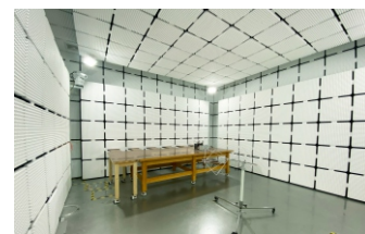
高压新能源 辐射发射暗室
