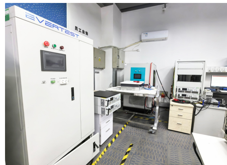
光伏储能测试平台
